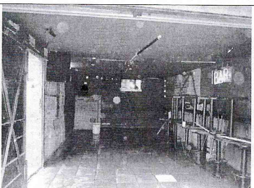
Foto 6. Muros y elementos de primer piso sin daño visible.
