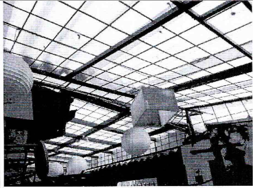
Foto 20. Cubierta en teja traslucida sin daños visibles.
