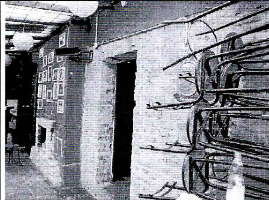
Foto 8. No se detectan daños en elementos internos.
