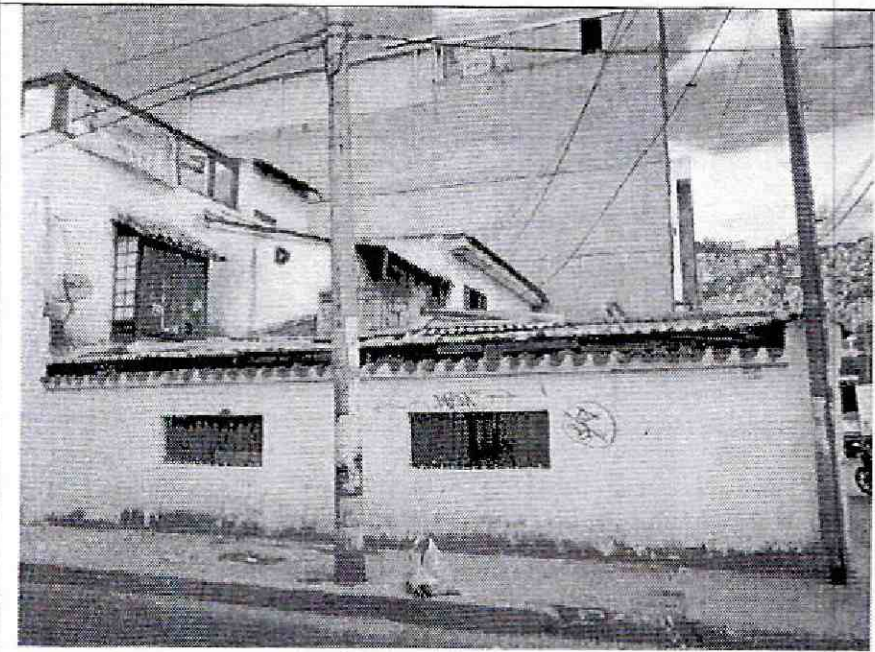
Foto 3. Muro de fachada y cerramiento costado occidental.
