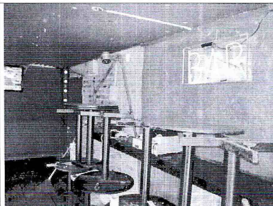
Foto 11. Muro interno del local sin daño evidente.
