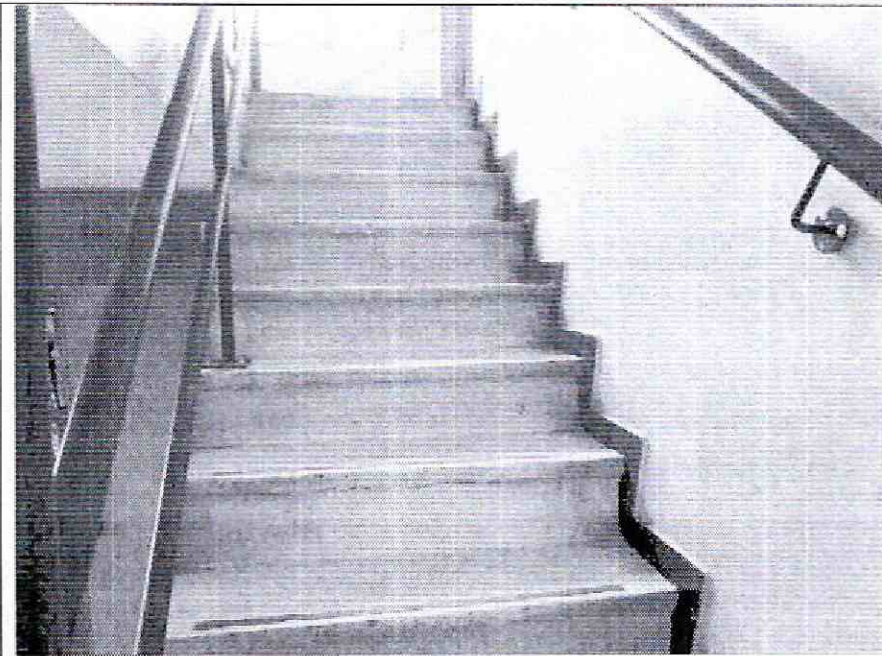
Foto 12. Escaleras sin daño estructural visible.
