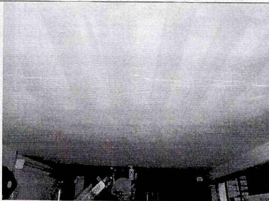
Foto 10. Cara inferior del entrepiso sin afectaciones.
