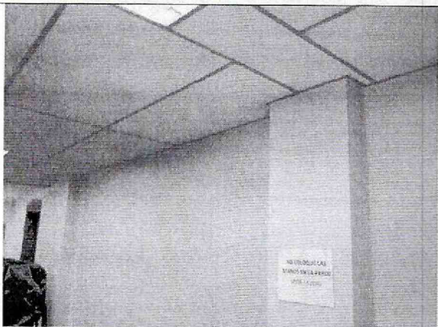
Foto 9. Columnas en segundo piso sin daños visibles.
