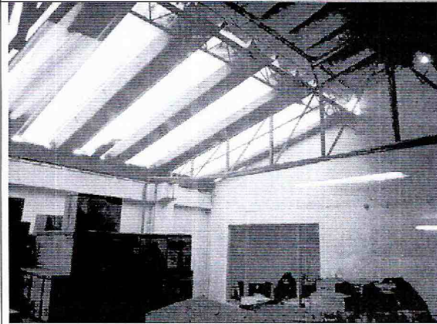
Foto 14. Cubierta en buenas condiciones.
