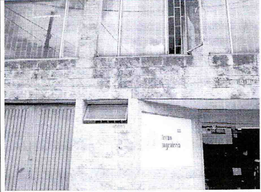
Foto 2. Muro de fachada sin daño visible.
