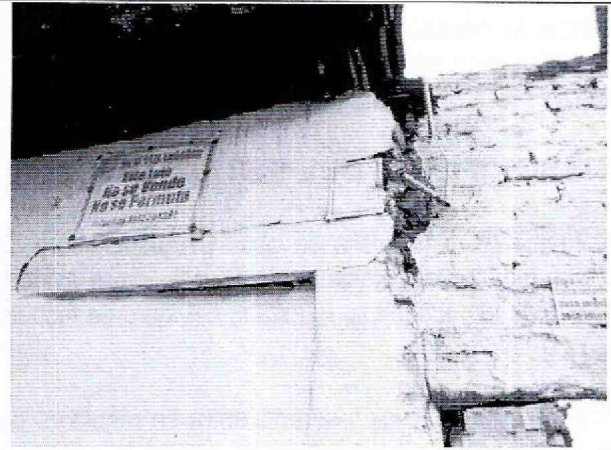
Foto 4. Grieta por junta entre adobes y ladrillos.
