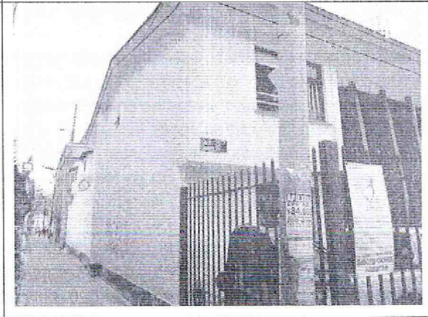
Foto 6. Muro lateral y de fachada sin afectaciones.
