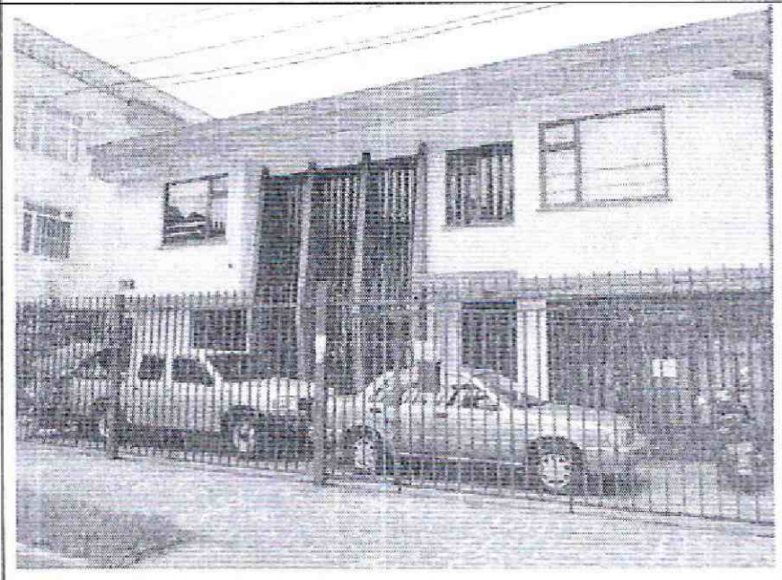
Foto 4. Fachada de la edificación del costado oriental.
