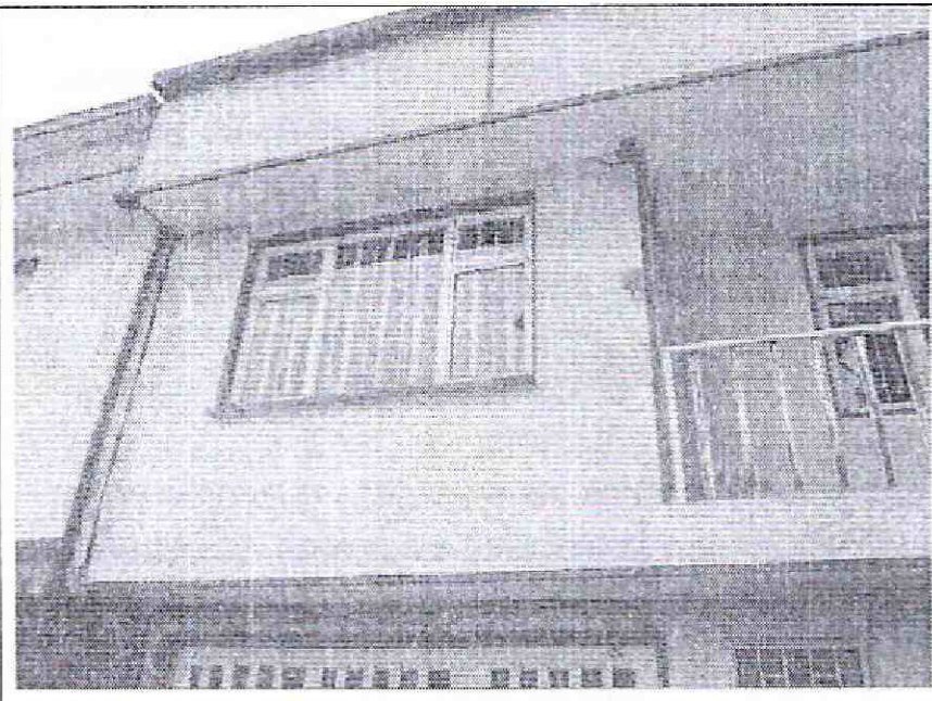
Foto 3. Fachada sin afectaciones visibles.
