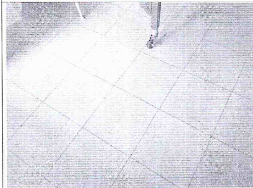
Foto 29. Pisos sin afectaciones visibles.
