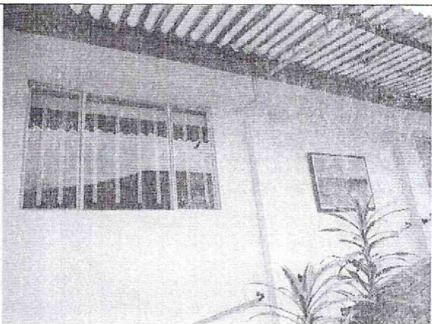
Foto 12. Muros de segundo piso sin afectaciones.
