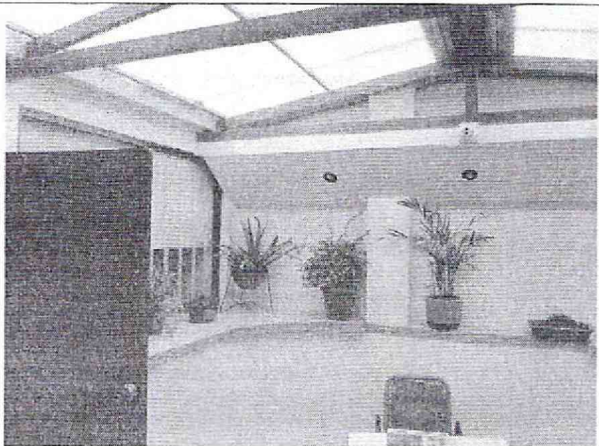
Foto 23. Muros de la edificación oriental sin daños.
