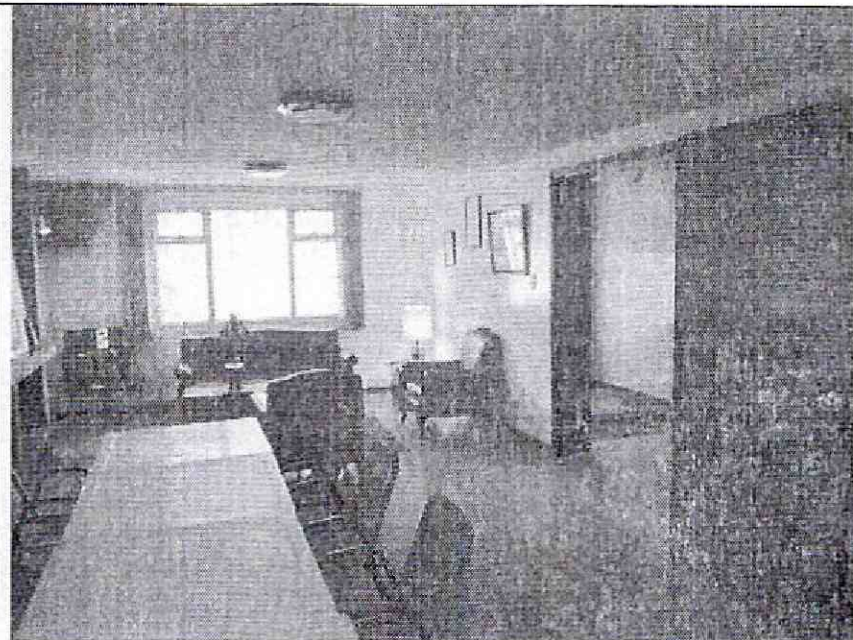
Foto 8. No se detectan daños en muros internos.
