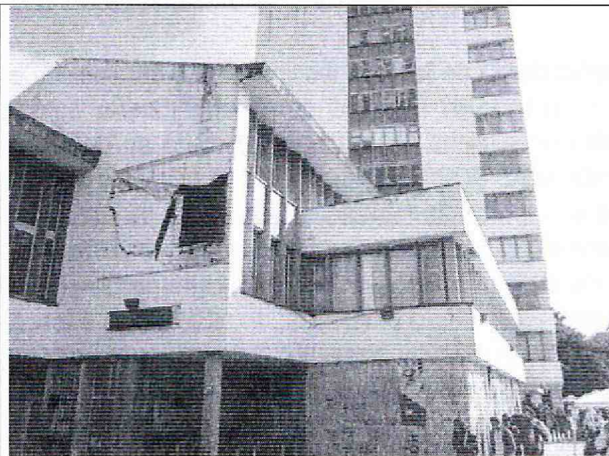
Foto 2. Fachada norte de la edificación.
