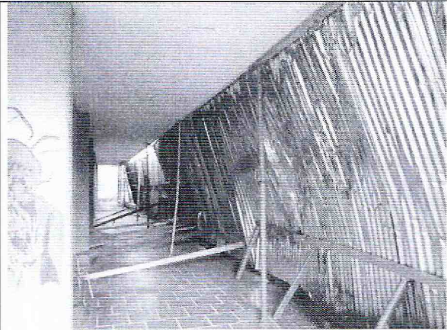
Foto 14. Apuntalamiento provisional, voladizo suroriental.
