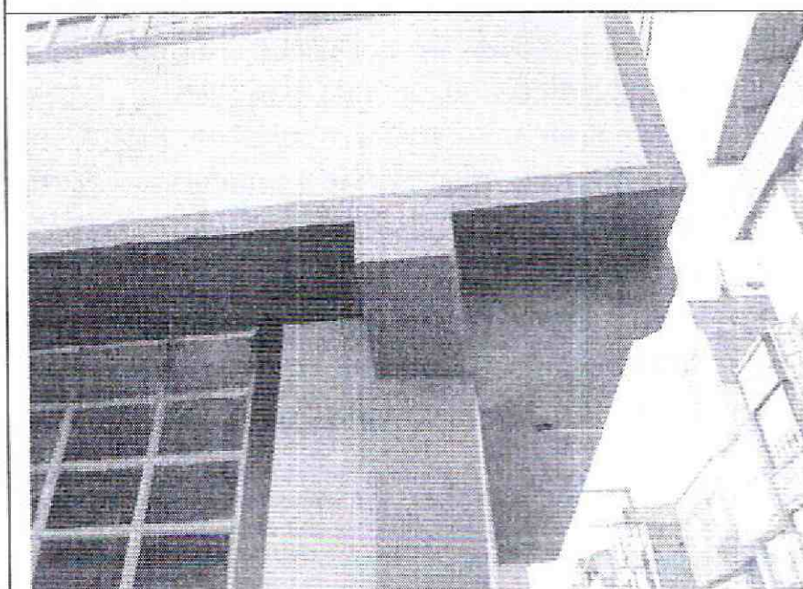
Foto 5. Elementos estructurales sin afectaciones visibles.
