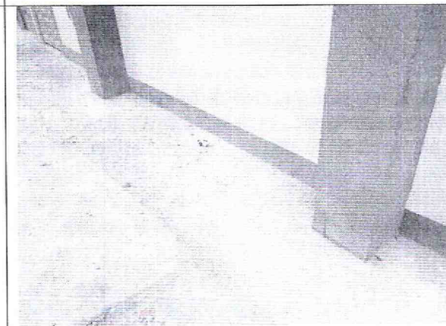
Foto 6. Andén sin evidencias de daños.
