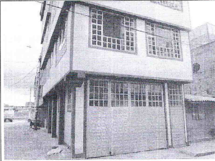
Foto 2. Muros de fachada en buenas condiciones.
