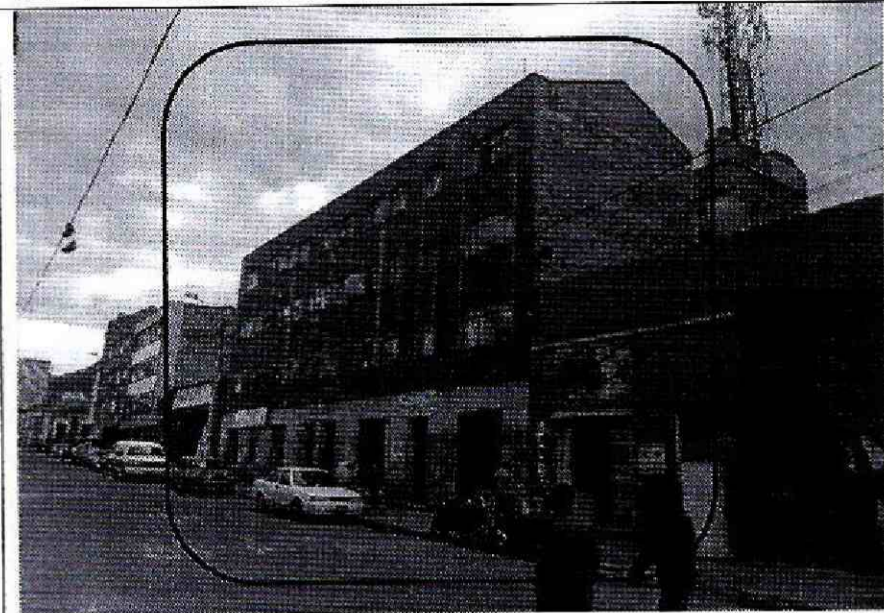
Foto 1. Vista general de la edificación.
