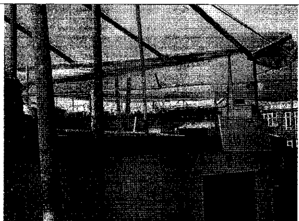
Foto 6. Cobertizo sobre placa de cubierta.
