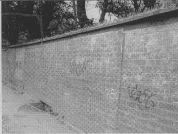
Foto 1. Aspecto general del muro objeto de la visita.
