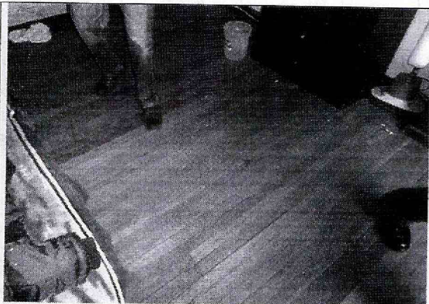
Foto 8. Tablado de entrepiso en buenas condiciones.
