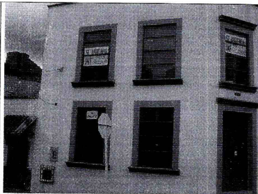
Foto 2. Fachada sur en buen estado.
