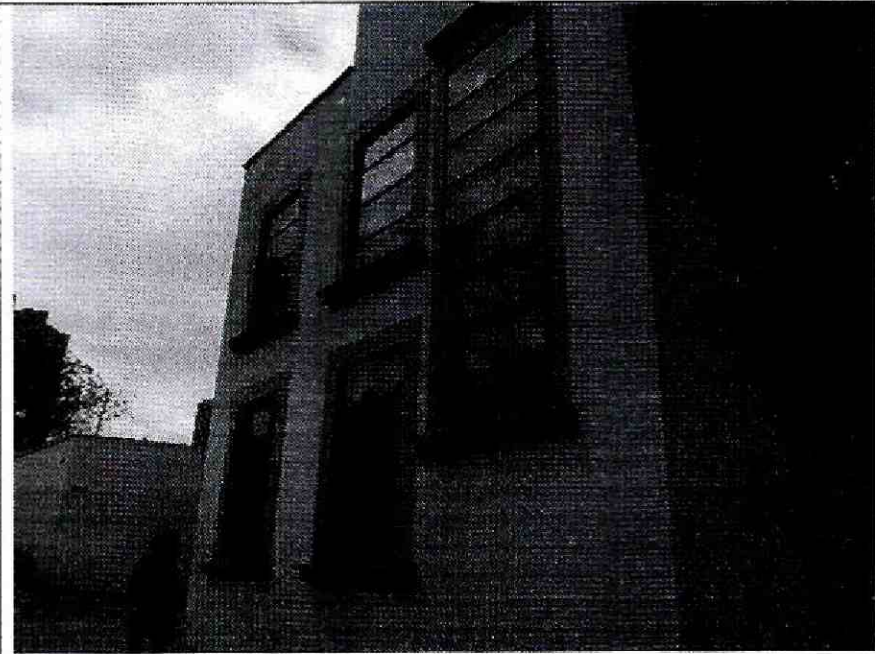
Foto 3. Fachada del costado oriental.
