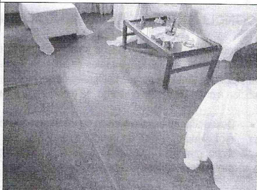
Foto 24. Acabados del entrepiso sin daño ni deterioro.
