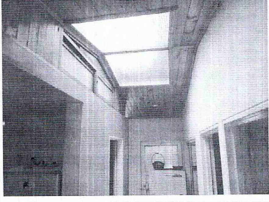
Foto 28. No hay evidencias de daños en cubierta.
