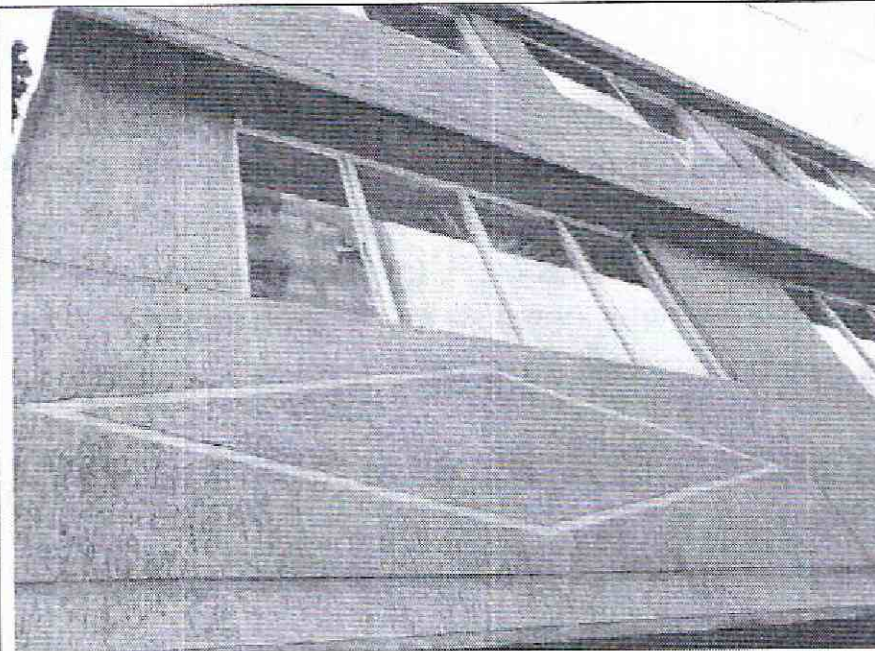
Foto 3. Muro de fachada de segundo piso sin daño visible.
