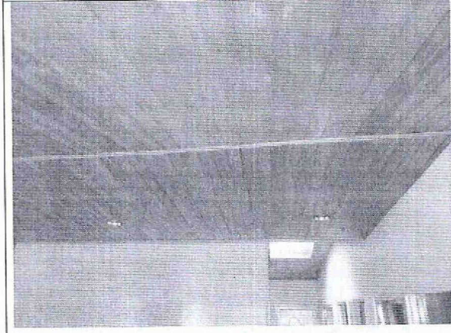
Foto 27. Cielo raso bajo cubierta en buen estado.
