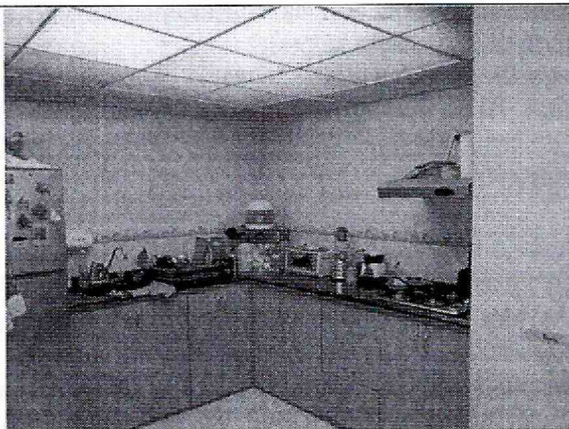
Foto 5. Muros del sector frontal sin daños.
