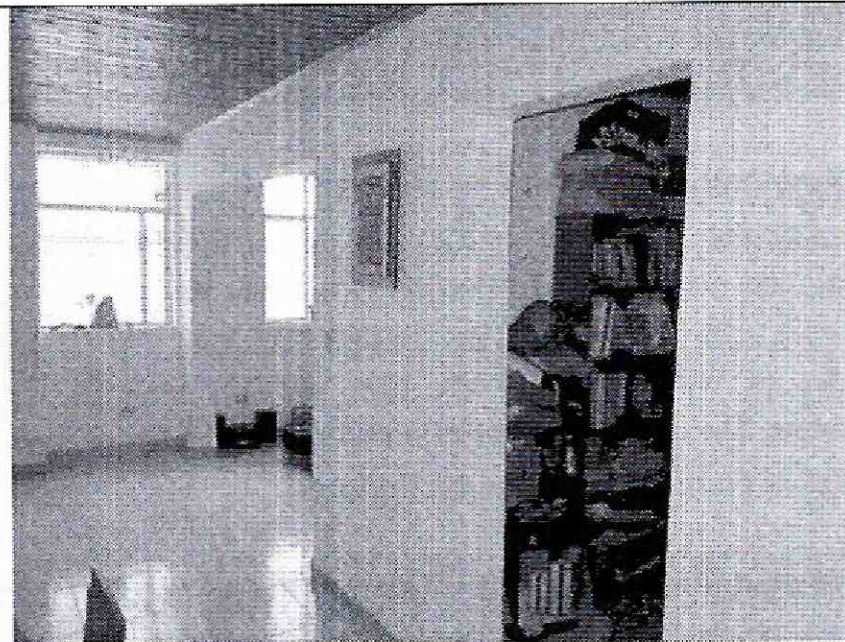
Foto 4. Muros internos sin afectaciones visibles.
