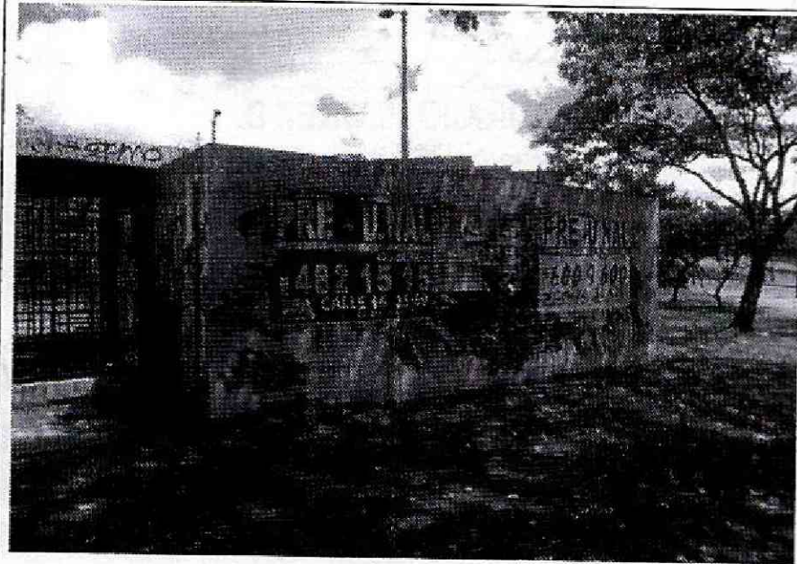
Foto 8. Vista de los muros externos de la edificación 2.
