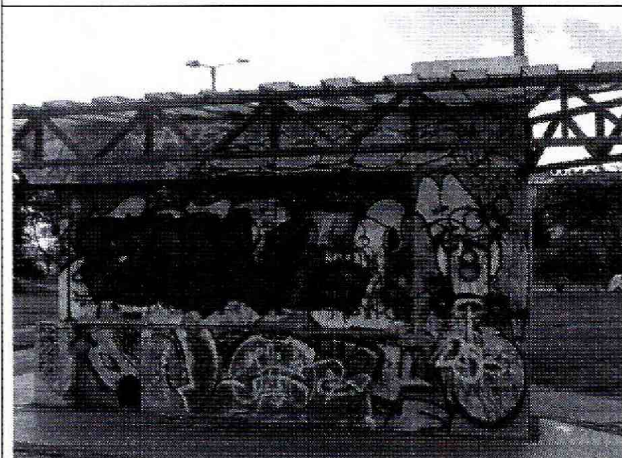
Foto 3. Muros externos en buen estado, edificación 1.
