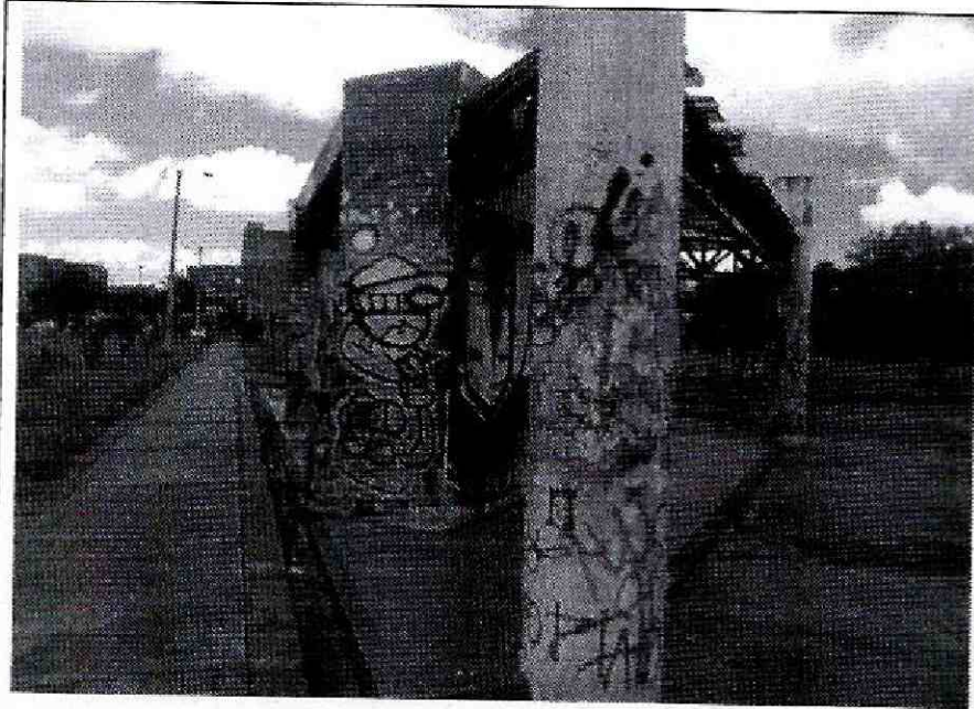
Foto 5. Columnas de soporte de la cubierta en buenas condiciones.
