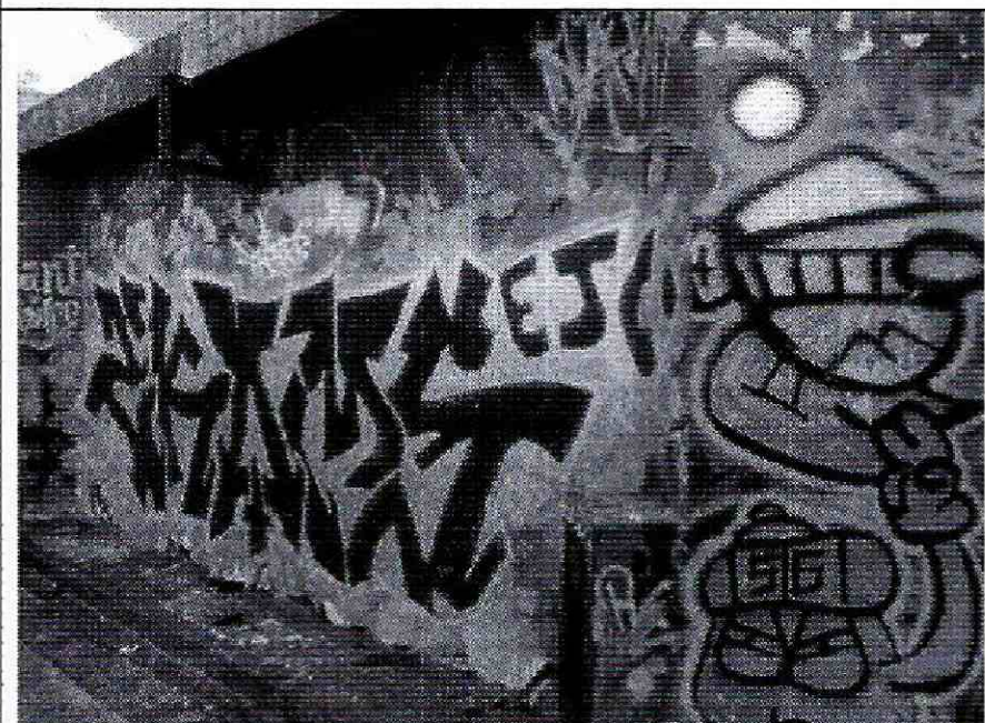
Foto 4. Aspecto de los muros externos de la edificación 1.
