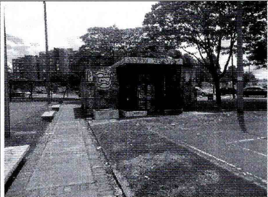
Foto 2. Aspecto de la fachada edificación 2.
