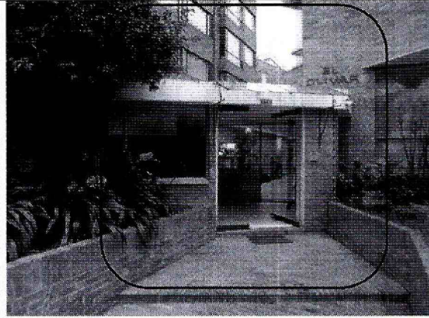
Foto 1. Vista del acceso al conjunto residencial.
