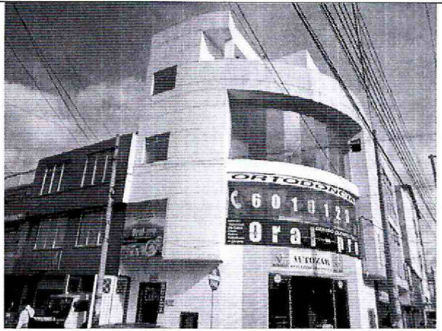
Foto 2. Muros de fachada en buenas condiciones.
