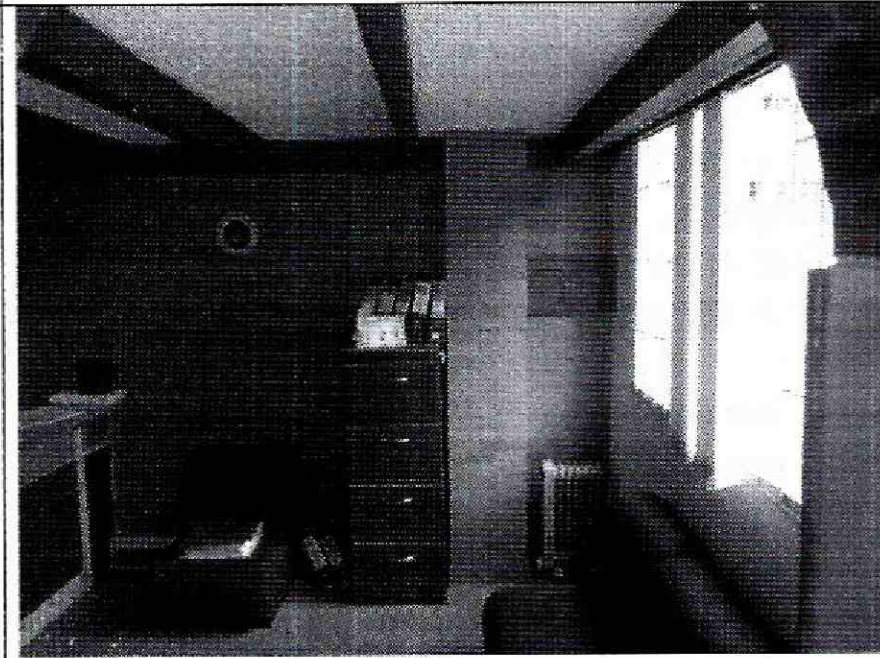
Foto 6. Aspecto general de los muros internos.
