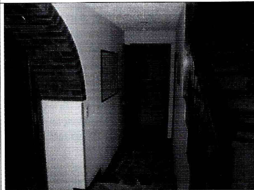
Foto 5. Muros del primer piso en buenas condiciones.
