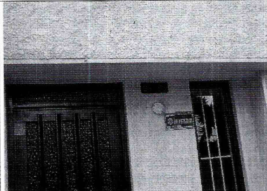
Foto 4. Fachada en buen estado.
