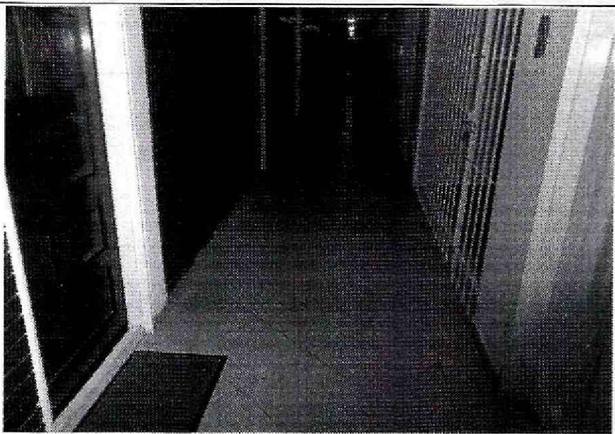
Foto 7. Acabados de piso en primer nivel en buen estado.
