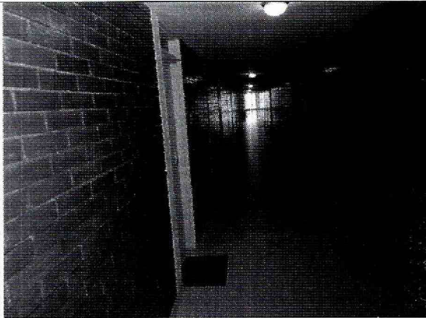
Foto 9. Muros internos de los pasillos en buen estado.
