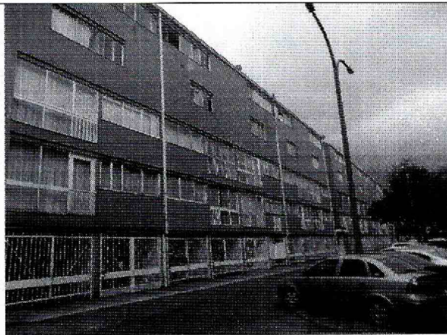
Foto 1. Vista general de la edificación.
