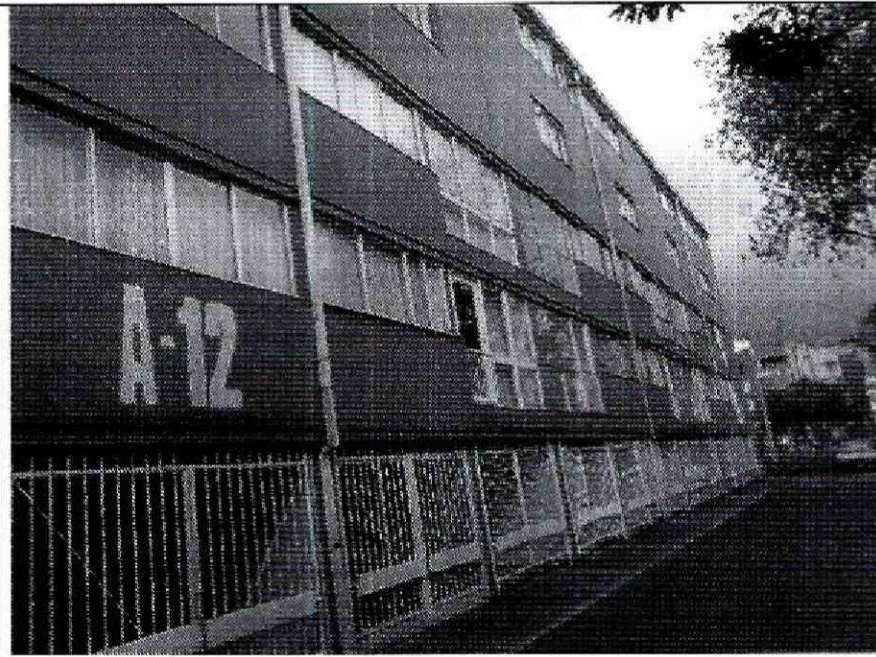
Foto 2. Elementos de fachada del costado sur en buenas condiciones.
