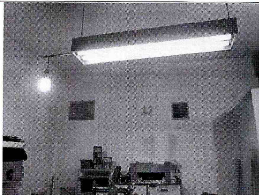
Foto 23. Muros del costado norte sin evidencia de daños.
