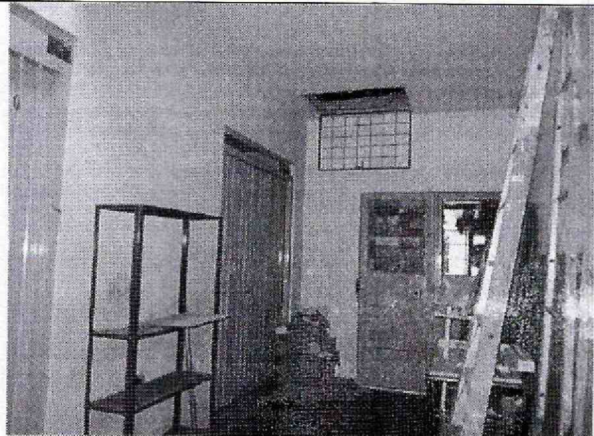
Foto 22. Buen mantenimiento de muros del sector central.
