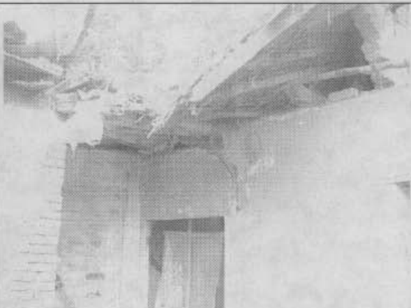
Foto 2. Cubierta colapsada.
