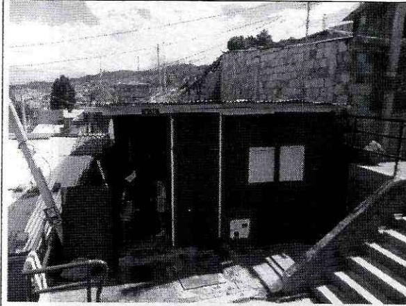
Foto 1. Vista general del inmueble objeto de la visita técnica.
