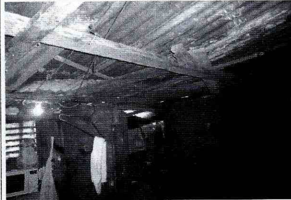
Foto 6. Elementos de madera de soporte de la cubierta.
