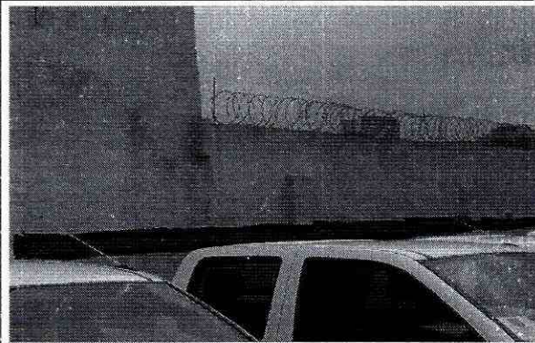
Foto 5. Muro lateral de lindero del costado sur en buen estado.
