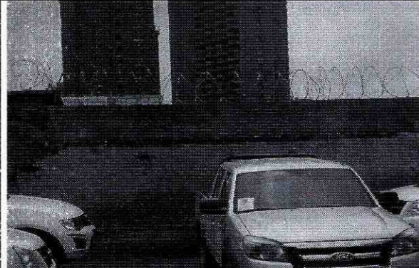
Foto 6. Vista del muro de la parte posterior.
