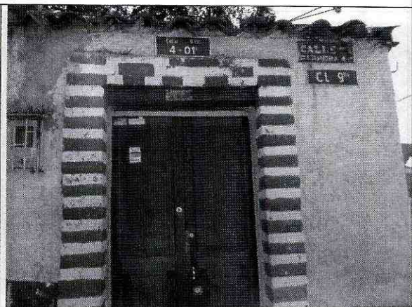
Foto 2. Muro de acceso a la edificación.
