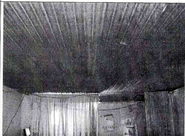
Foto 10. Entrepiso en buen estado.
