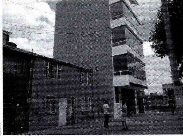
Foto 2. Muro de fachada de la edificación.
