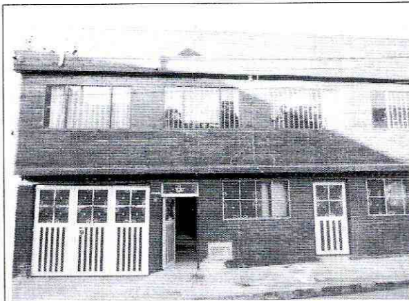
Foto 1. Vista general del exterior del inmueble del concepto
