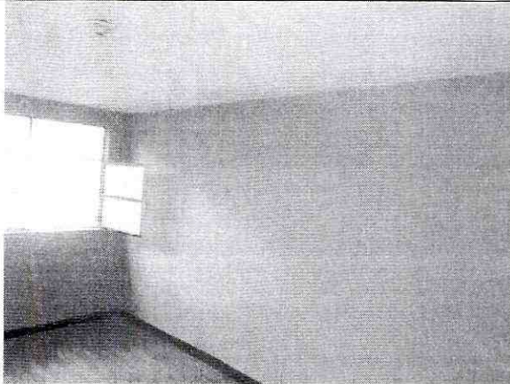
Foto 9. Semisótano sin daño estructural visible.
