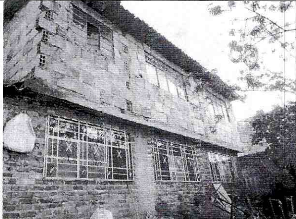
Foto 8. Muros en zona del patio posterior sin afectaciones.
