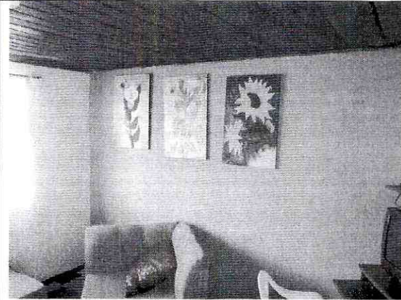
Foto 5. No se detectan daños en los muros internos.
