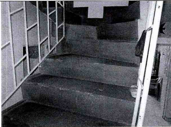
Foto 17. Escaleras en buenas condiciones estructurales.
