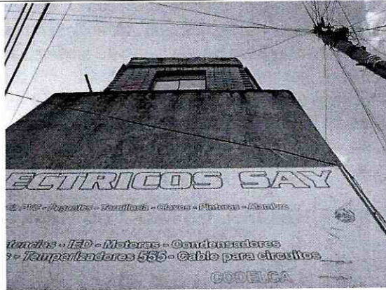
Foto 2. Sector central de la fachada del segundo nivel.
