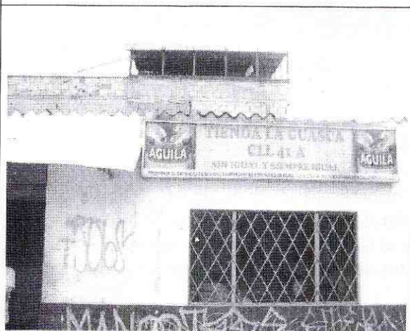
Foto 3. Parte occidental de la vivienda
