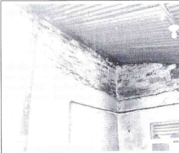
Foto 5. Cubierta y muro típico del inmueble
