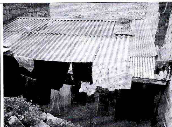
Foto 13. Cubierta del sector frontal en buenas condiciones.
