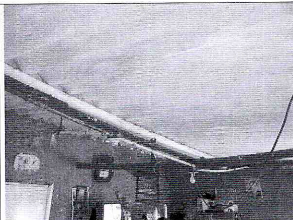
Foto 14. Cubierta del sector posterior sin daños.
