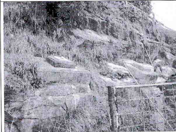
Foto 16. Elementos de estabilización del talud cercanos.
