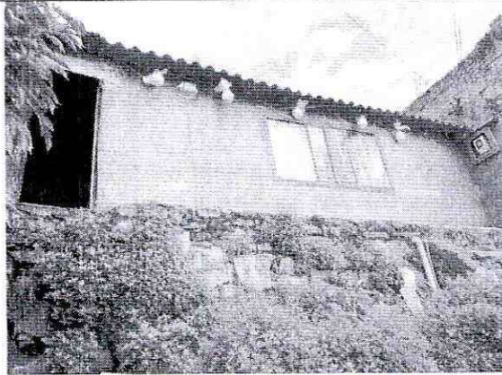
Foto 3. Muro de fachada sin afectaciones visibles.
