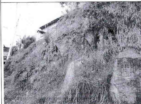
Foto 15. Talud frente a la edificación.
