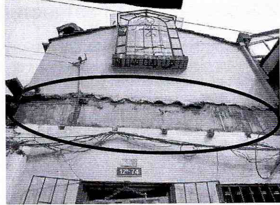
Foto 2. Retiro del alero a nivel del entrepiso.
