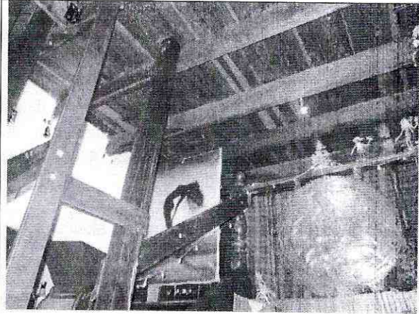
Foto 8. Entrepiso en madera sin daño visible.
