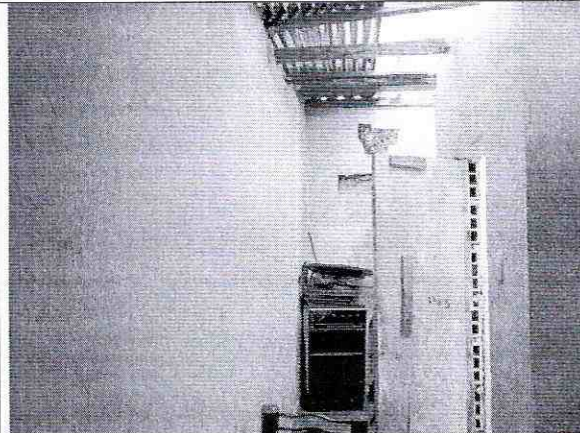
Foto 16. El sector norte no presenta deterioro.
