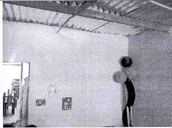
Foto 14. Muros del sector norte sin daños, sector habitado.
