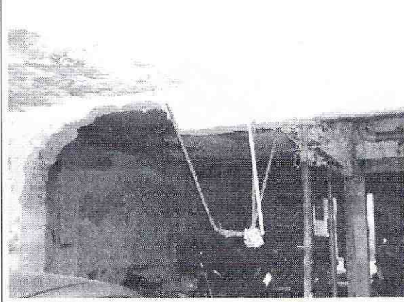
Foto 16. Cimbras para soporte en muros demolidos
