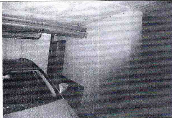
Foto 3. Pantallas en la zona de los garajes en buen estado.
