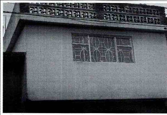
Foto 2. Muros de fachada en buen estado.
