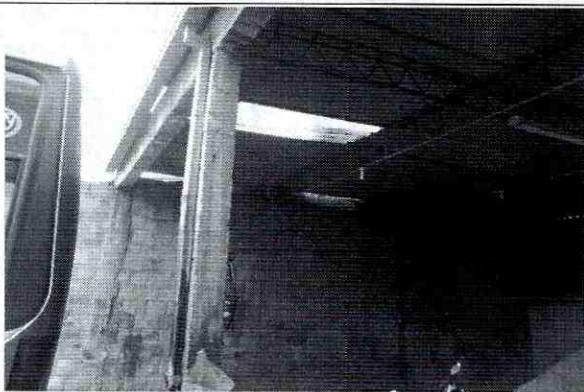
Foto 5. Columnas en concreto del cobertizo en buenas condiciones.
