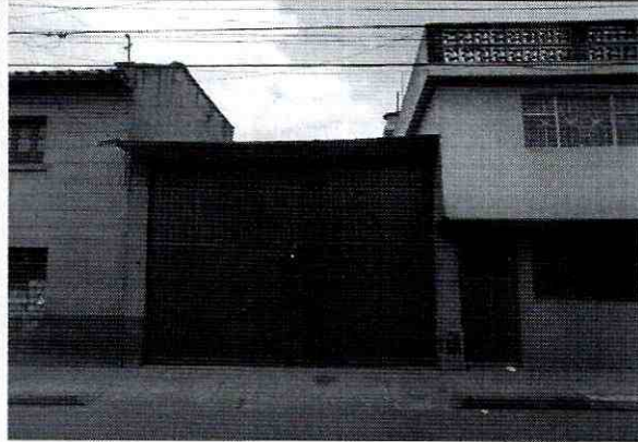
Foto 1. Vista general de la fachada del inmueble.
