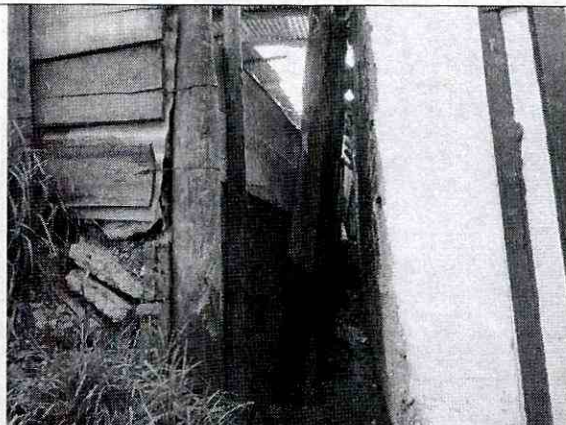
Foto 10. Elementos en contacto con cubierta y muros.
