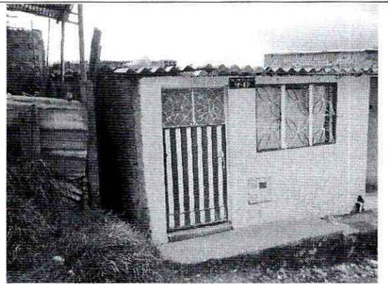
Foto 2. No se observan daños de muros de fachada.
