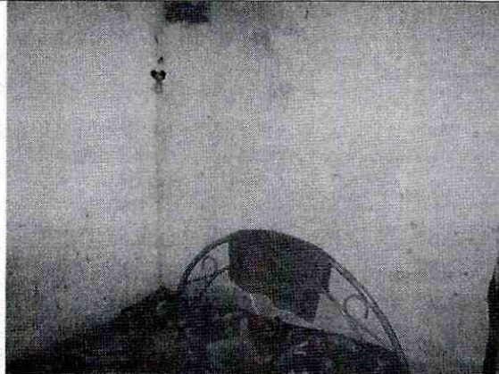
Foto 7. Muros sin daño visible, en buenas condiciones.
