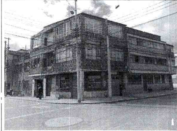
Foto 1. Vista general del inmueble donde se localiza el muro de lindero.
