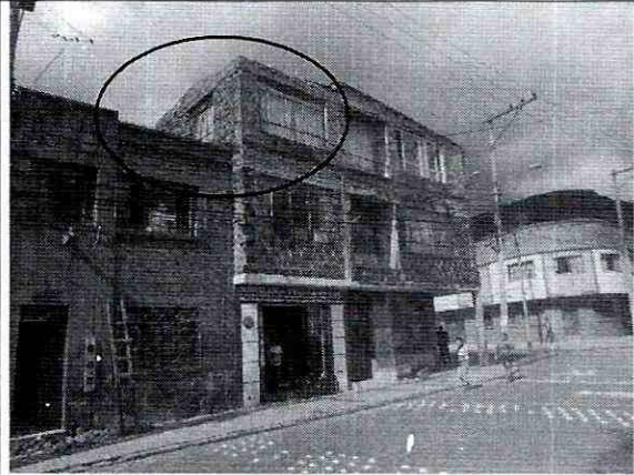
Foto 2. Costado occidental del predio, ubicación del muro de lindero.
