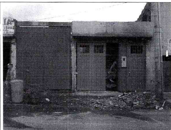
Foto 1. Vista general de la fachada de la edificación.
