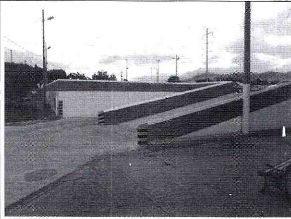
Foto 3. Vista de la rampa de acceso.
