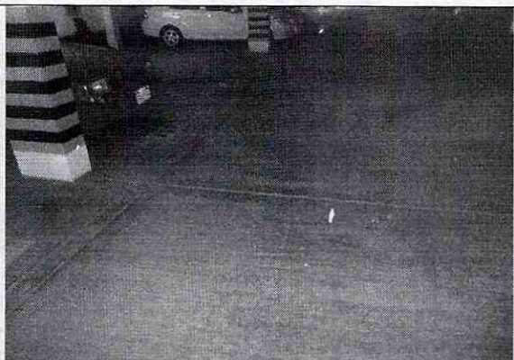
Foto 10. Placa de piso de los parqueaderos.
