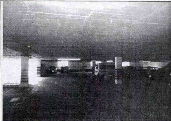
Foto 6. Vista de la cara inferior de la placa de parqueadero.
