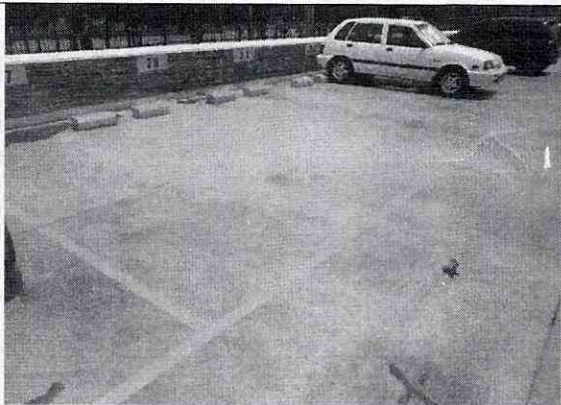
Foto 7. Acabado de placa en buenas condiciones
