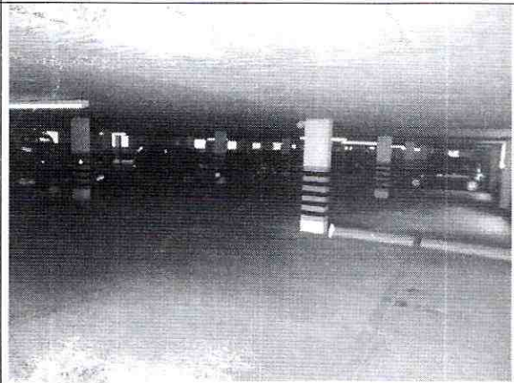
Foto 4. Columnas del parqueadero en buen estado
