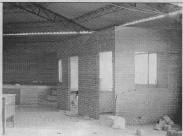
Foto 6. Muros internos de la edificación.
