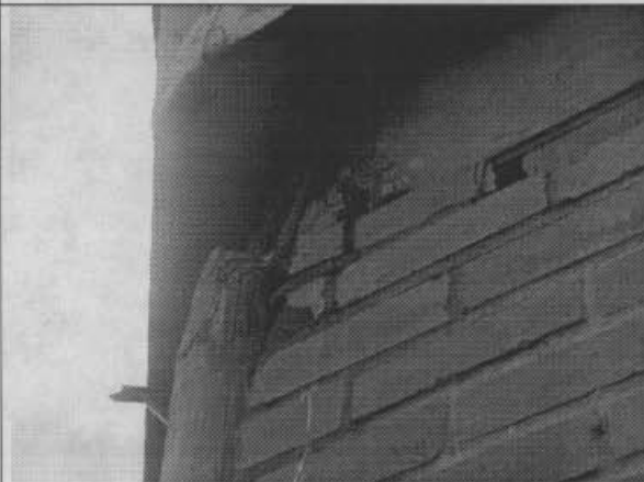
Foto 10. Rotación de un nudo de la estructura.
