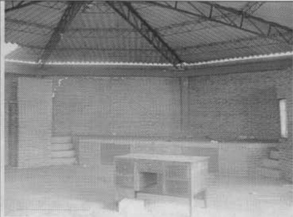
Foto 2. Aspecto interior de la estructura y cubierta.
