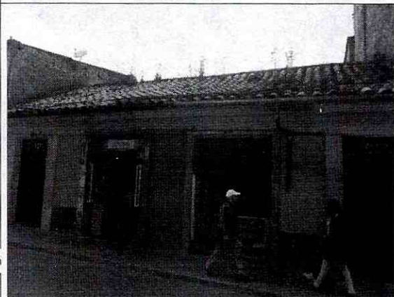
Foto 13. Aspecto de la cubierta de la edificación.
