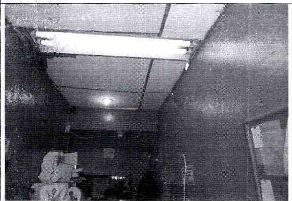
Foto 8. Vista del cielo raso bajo la cubierta.
