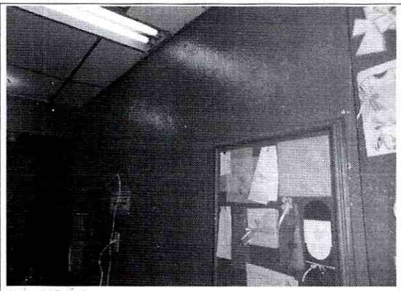
Foto 4. Acabados de muros internos en buenas condiciones.
