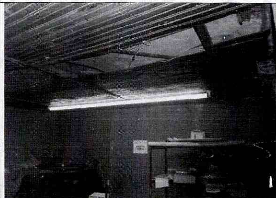
Foto 11. Cielo raso en madera del local ubicado en la nomenclatura No. 9 - 57
