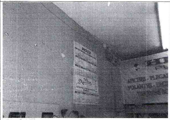
Foto 6. Muros internos en buen estado.
