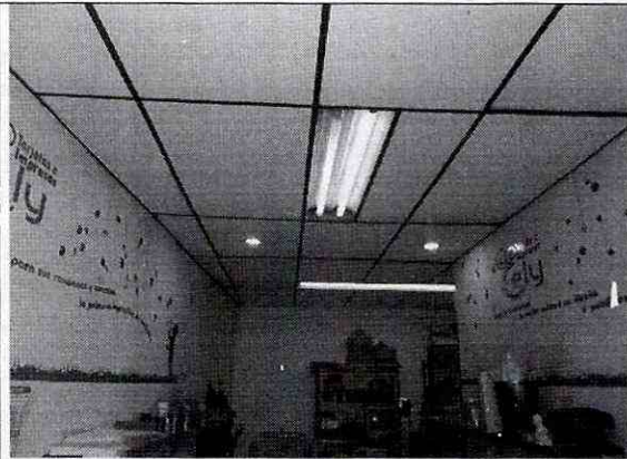
Foto 9. Elementos de cielo raso en buenas condiciones.
