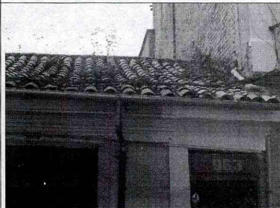
Foto 14. Cubierta del extremo norte de la edificación.
