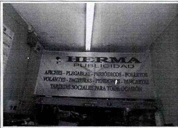
Foto 10. Acabados del cielo raso en buen estado.
