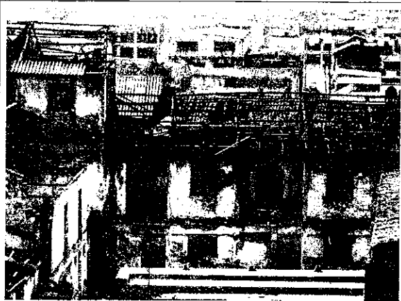
Foto 8. Edificación de la zona posterior en el costado occidental
