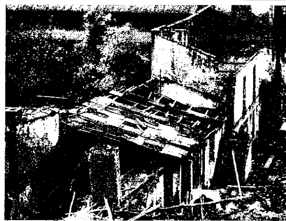
Foto 9. Edificación de la zona posterior en el costado sur
