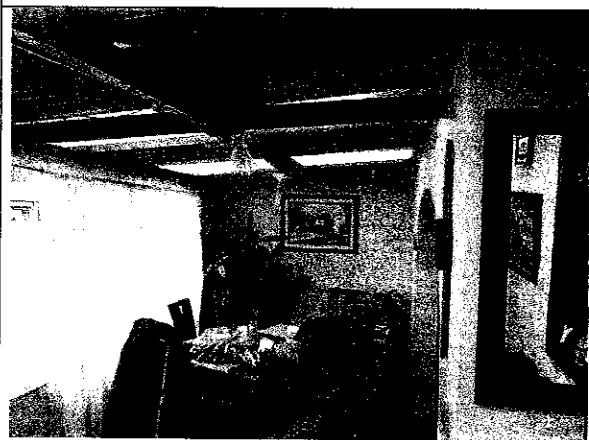
Foto 15. Elementos de cubierta sin daño visible.
