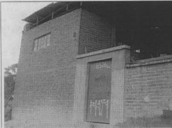
Foto 11. Edificación de dos pisos en la esquina suroccidental.
