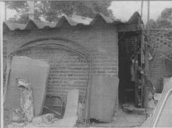
Foto 6. Construcción en mampostería y canaleta.
