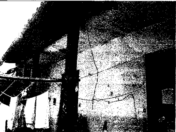
Foto 13. Columnas de madera en buenas condiciones.
