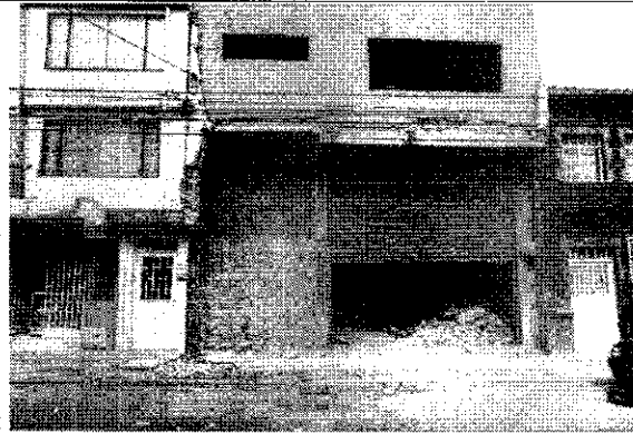
Foto 2. Elementos de fachada en buen estado.
