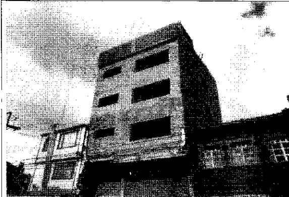
Foto 1. Vista general de la edificación.
