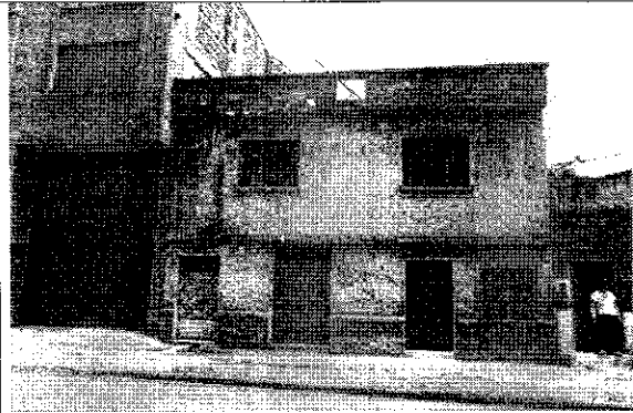
Foto 1. Vista general de la fachada de la edificación.
