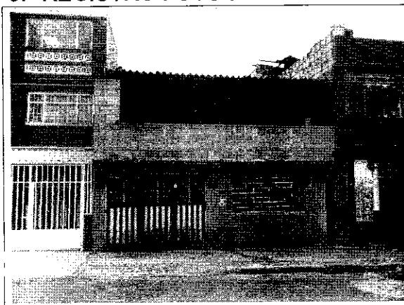
Foto 1. Vista de la fachada del inmueble.
