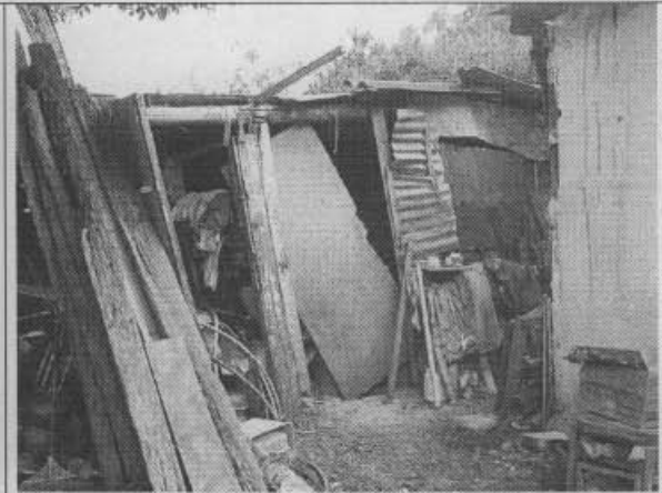
Foto 2. Estructura ubicada en el costado norte del inmueble, construida con materiales de recuperación y con deficientes condiciones estructurales.
