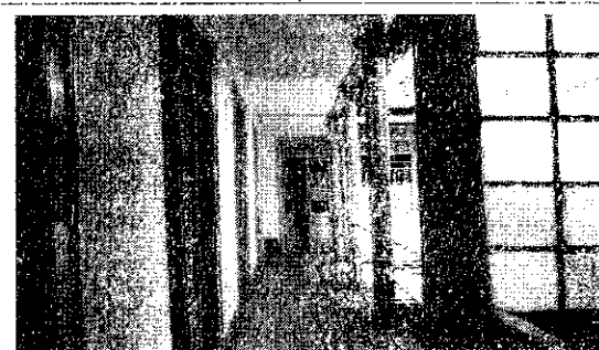
Foto 4. Estado de los corredores de la parte frontal de la edificación.
