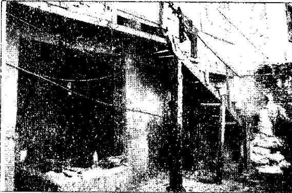
Foto 19. Escaleras de acceso al patio posterior de la edificación.
