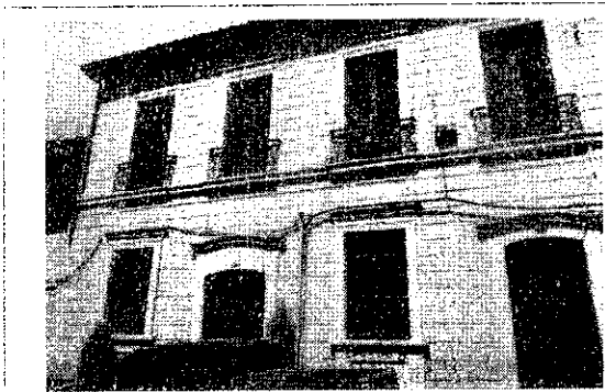
Foto 1. Vista de la fachada.
