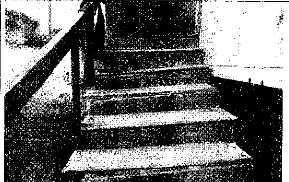
Foto 20. Se observa el mal estado de las escaleras de acceso al patio posterior.
