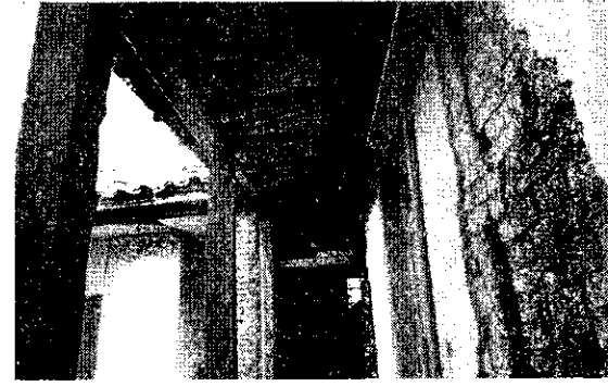
Foto 10. Vista actual del cieloraso en el segundo nivel. Se observa que se realizaron reparaciones por parte de los residentes.
