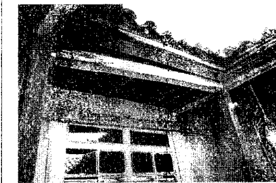
Foto 11. Vista de los aleros de madera afectados en la parte posterior de la edificación.
