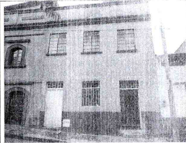
Foto 1. Aspecto general de la fachada (costado occidental) de la edificación emplazada en el predio de la Carrera 3 A Bis No. 31 A- 4. Se observa un buen estado de conservación.
