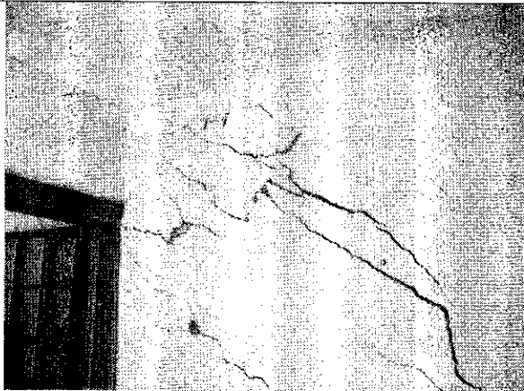
Foto 9. Agrietamientos en muro de segundo piso.
