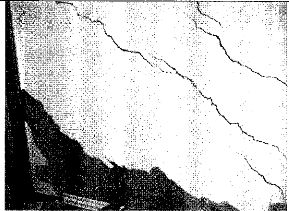
Foto 8. Agrietamientos y pérdida de acabado de muros.
